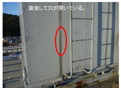
老朽高置水槽
