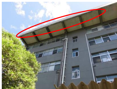
老朽建物軒庇（築50年）
